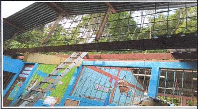
Foto 2: Cambio de lamina y canales
